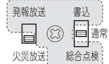
発報放送／火災放送 切換スイッチ 火災放送時 (Aの刻印が裏)
